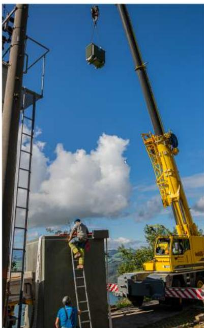
Hoch über dem Zugersee wird der Trafo in die neue Trafostation gekrant.
