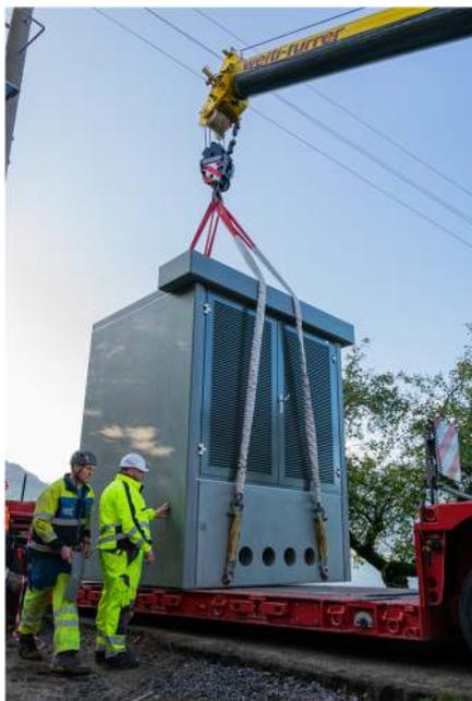
Ersetzt werden die Maststationen durch Trafostationen.
