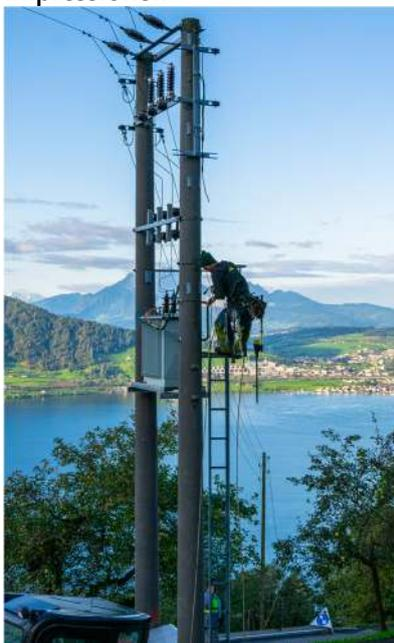
Oberhalb von Walchwil: Ein WWZ-Monteur erdet die Maststation Gibel vor dem Kraneinsatz. Fünf dieser Maststationen werden zwischen Walchwil und Zugerberg zurückgebaut.
