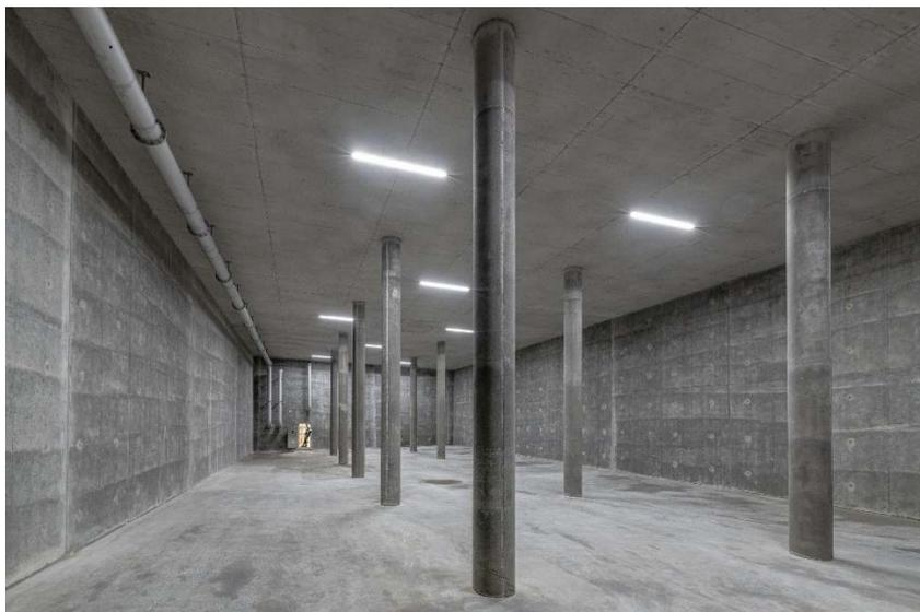
Jede der beiden neuen Kammern fasst 3000 m<sup>3</sup> Trinkwasser.
