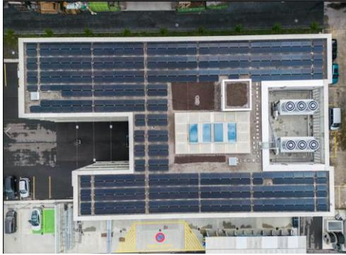
375 PV-Module am Hauptsitz von WWZ produzieren Solarstrom fürs Rechenzentrum Choller.
