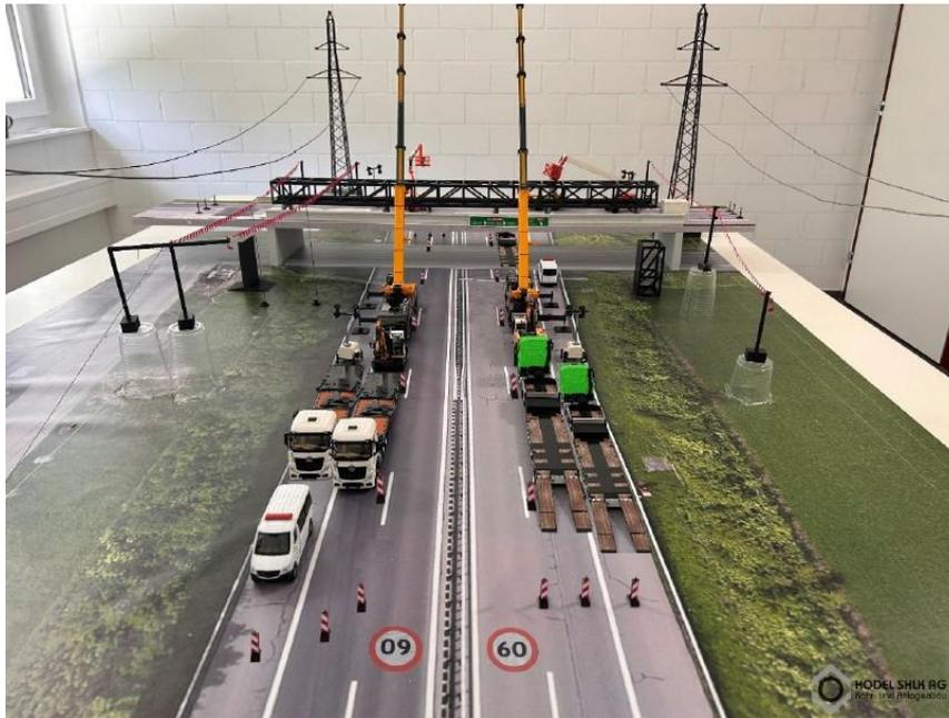
Bild Visualisierung Spurabbau
