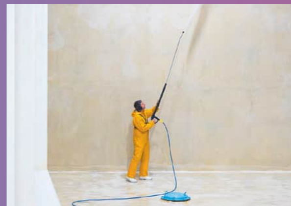
Während das Wasser abgelassen ist, wird eine der beiden Kammern gereinigt.
