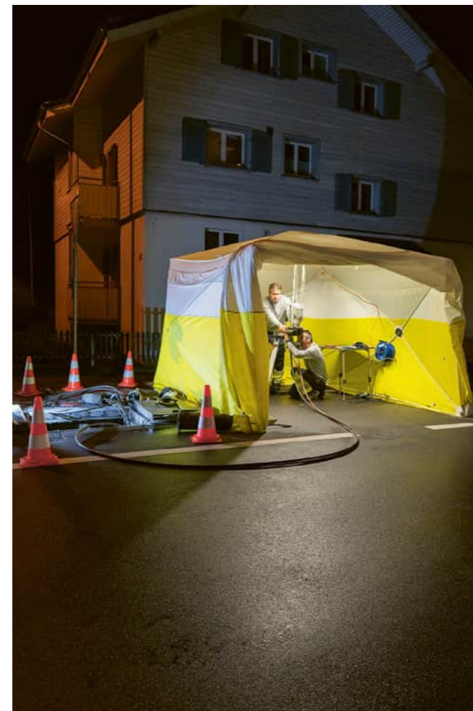
Im Spleisszelt werden die Glasfaserkabel miteinander verbunden.
