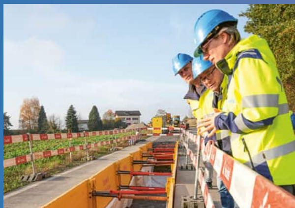
Vorbereitungsarbeiten für die Verlegung der Fernwärmeleitungen in Holzhäusern.
