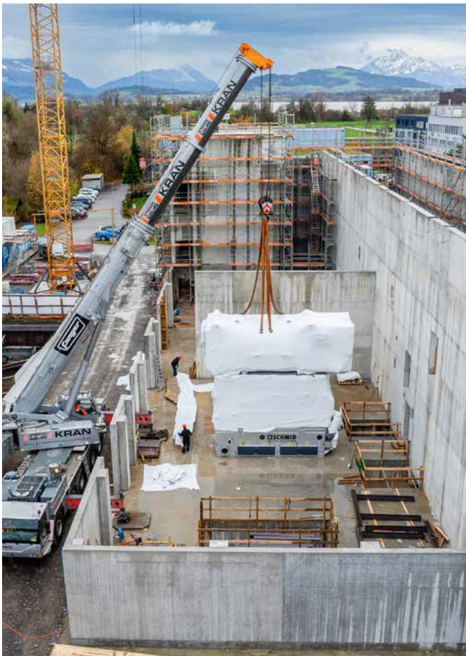
In Steinhausen entsteht eine moderne Energiezentrale, die ab 2026 nachhaltige Wärme liefert.
